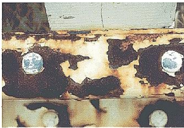
Figura 6.1 a.- Corrosión uniforme y corrosión intreganular
