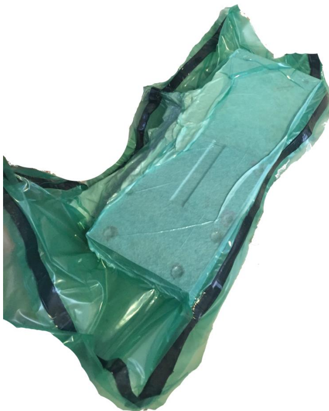
Figura 4.34 Molde inferior cerrado, sellado y estrangulado al vacío previo a etapa de curado
