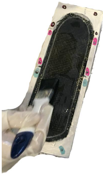
Figura 4.31 Aplicación de resina epoxi después de colocar fibra de carbono
