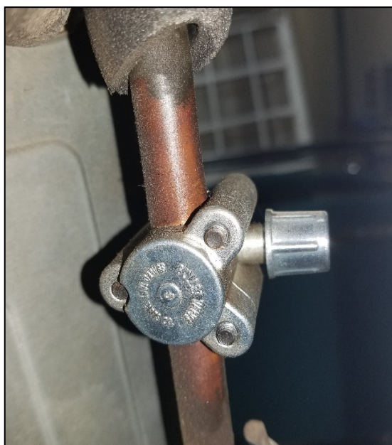
Figura 11. Válvula de servicio tipo perforadora.
