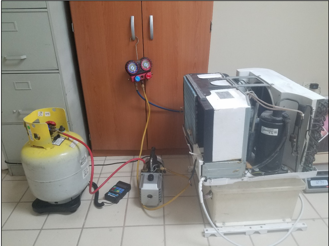
Figura 13. Tanque de recuperación y bomba de vacío.
