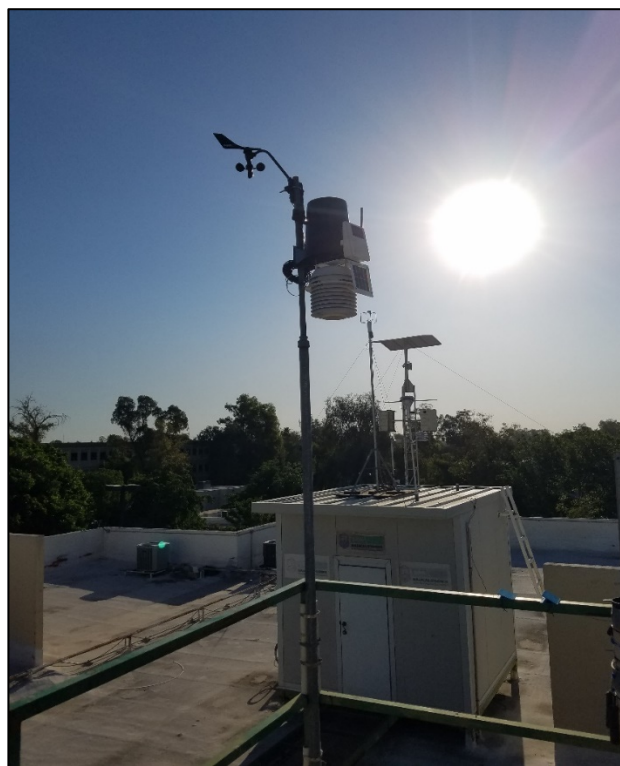
Figura 9. Estación Davis en plataforma de estudios meteorológicos del Instituto de Ingeniería.
