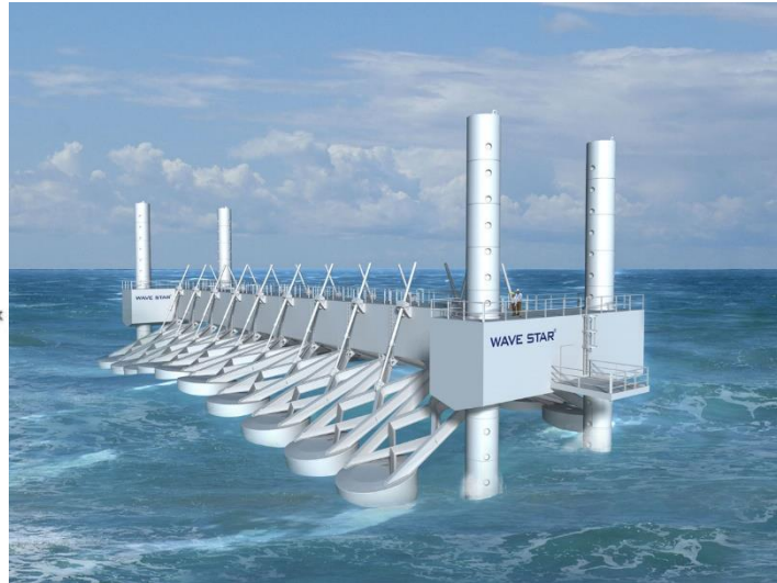
Figura 43. CEO compuesto por arreglo de boyas con anclaje al fondo (tomado de Babarit et al., (2012) y Wavestarenergy.com).
