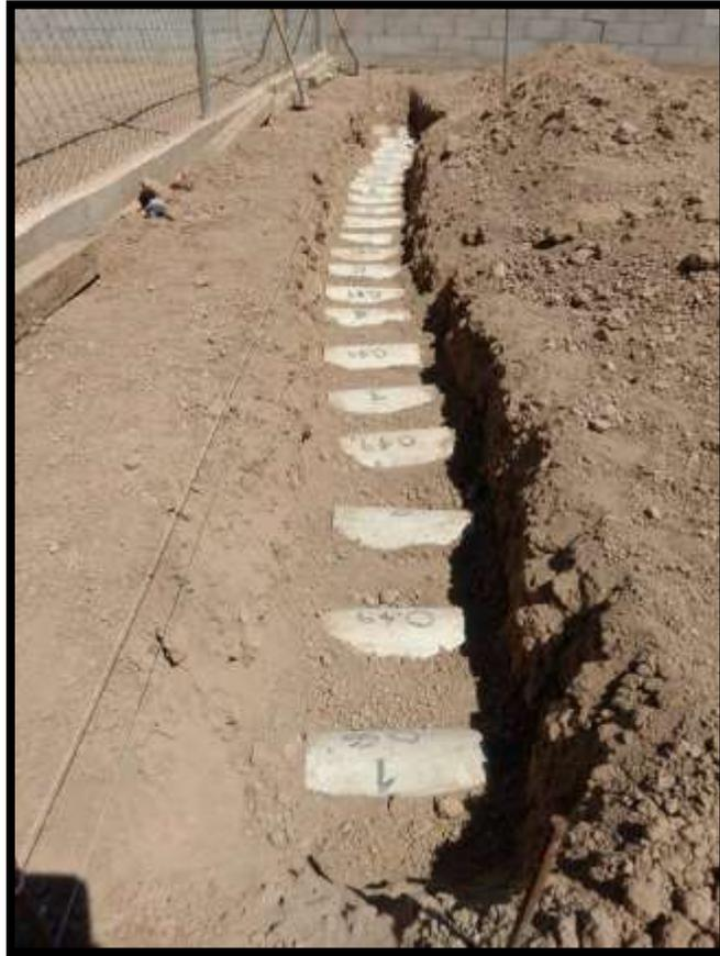
Una vez acomodados los cilindros se procedió a rellenar la zanja con la misma tierra que se había retirado, y aproximadamente cada 15 cm se compacto con pisón metálico hasta alcanzar el nivel natural del terreno.
