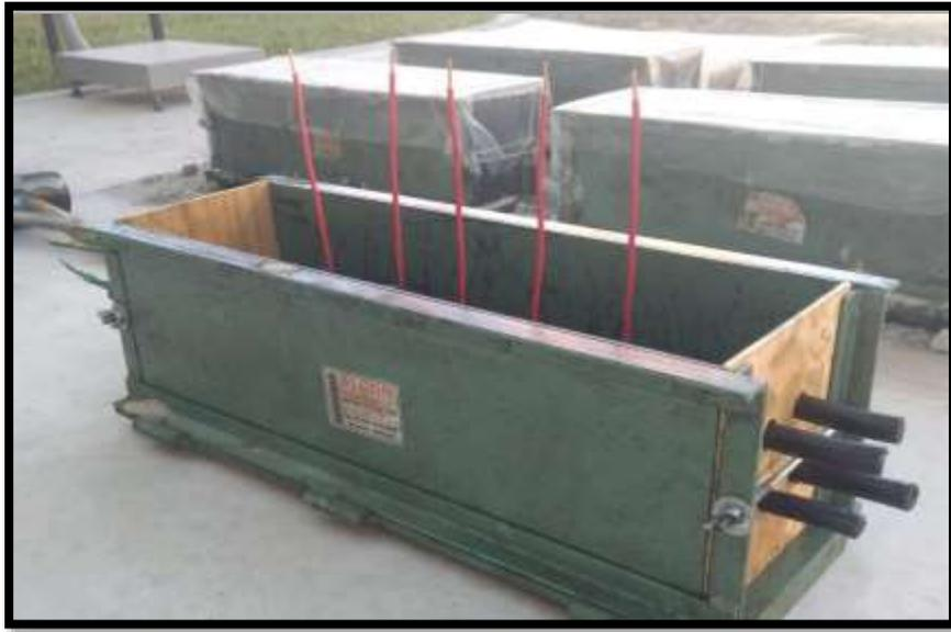
En cada extremo de las vigas las varillas longitudinales y los cables de conexión cuentan con protección del envolvente, siendo estas secciones las que quedaran fuera del cuerpo de la viga.
