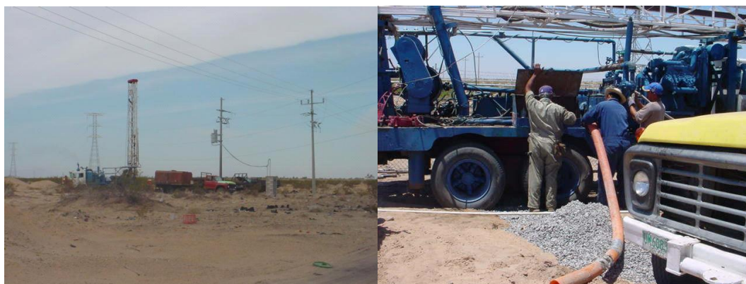
Figura 6. Perforación de los pozos realizados por la empresa CORSA S.A. de C.V.
