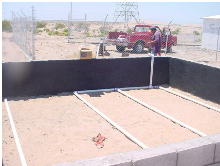
Figura 15. Instalaciones realizadas en la pileta.
