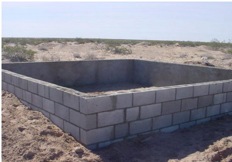
Figura 4. Construcción del Estanque o pileta.
