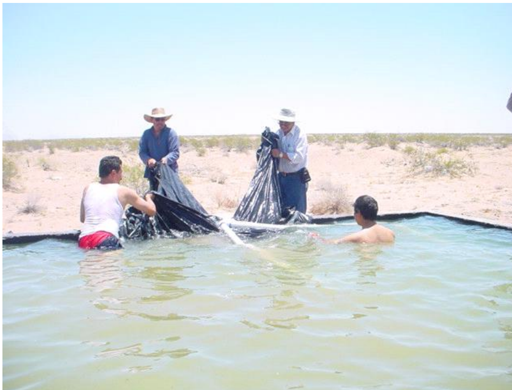
Figura 16. Prueba con agua del pozo profundo de la PTAR. Llenado de la pileta y retiro de la cubierta plástica.
