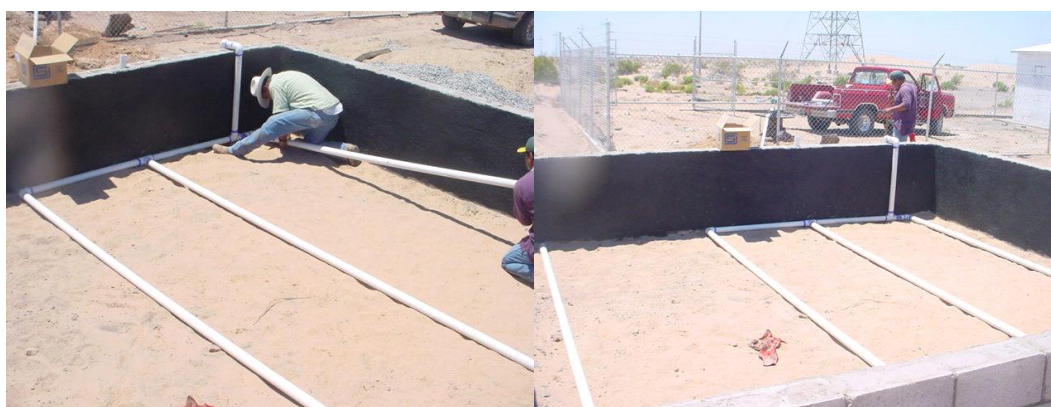
Figura 8. Instalación de tuberías en la pileta para su llenado.
