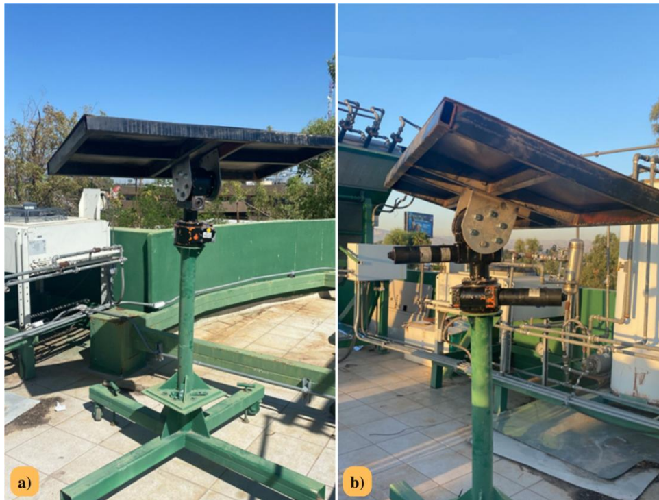
Figura 43. a) Estructura con la base para los módulos fotovoltaicos. b) Instalación de los motores a la estructura.
