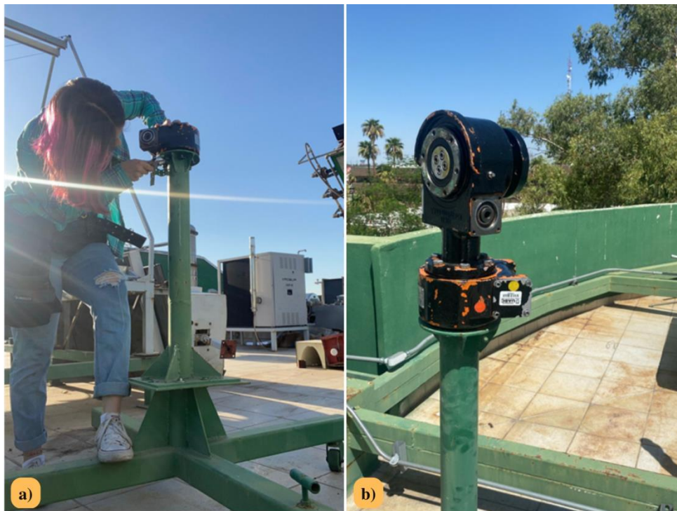
Figura 42. a) Colocación de las transmisiones. b) Transmisiones montadas en la estructura.
