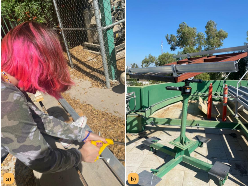
Figura 44. a) Corte del riel de aluminio. b) Rieles de aluminio instalados en la base para los módulos fotovoltaicos modificada.
