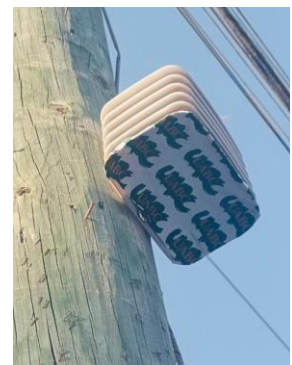
Tapa y colocación de las pantallas y sensores
