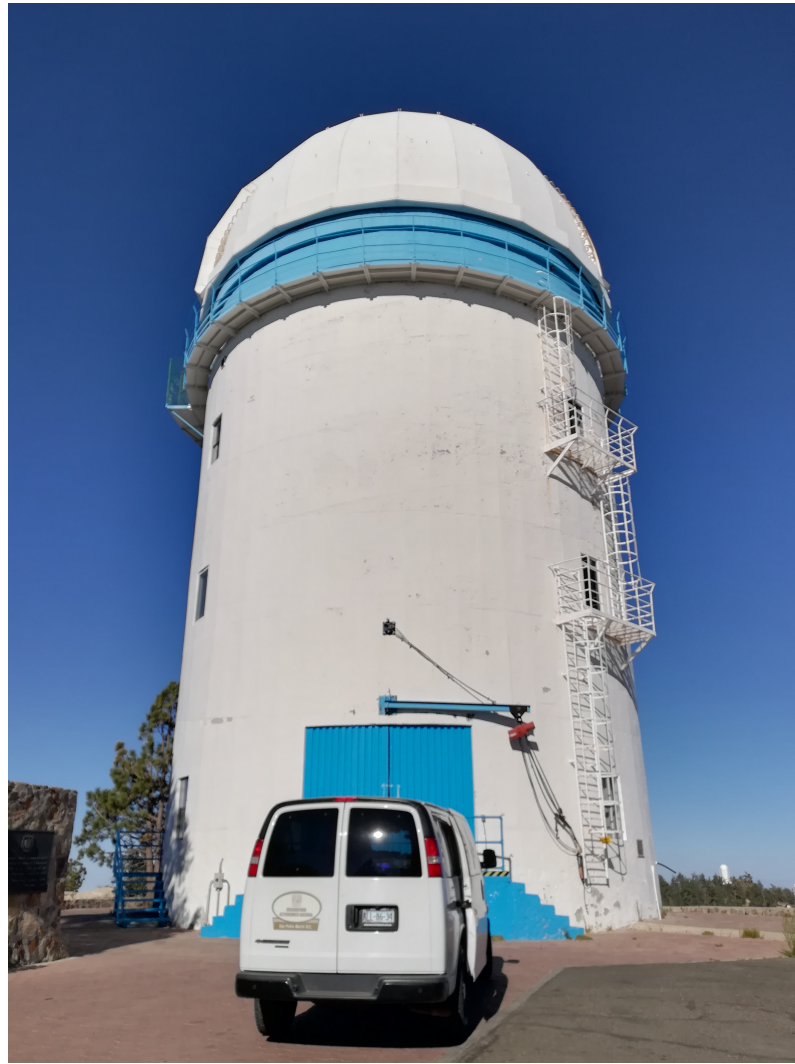
Figura 3.1: Edificio del telescopio de 2.1 m ubicado en el OAN-SPM.
