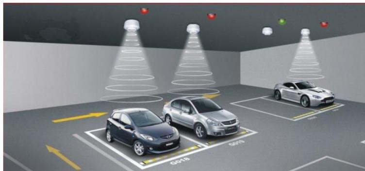
Figura 21: Sensores ultrasónicos en estacionamientos inteligentes.
