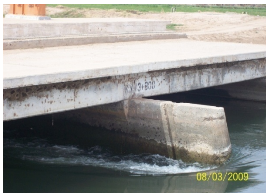
Figura 4.20. Tirante para el Canal Independencia en Concreto Asfaltico km 13+800.
