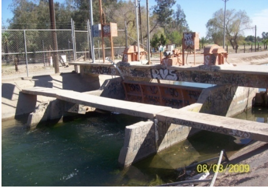
Figuras 4.23. Tirante para el Canal Independencia en Concreto Hidráulico km 56+466.
