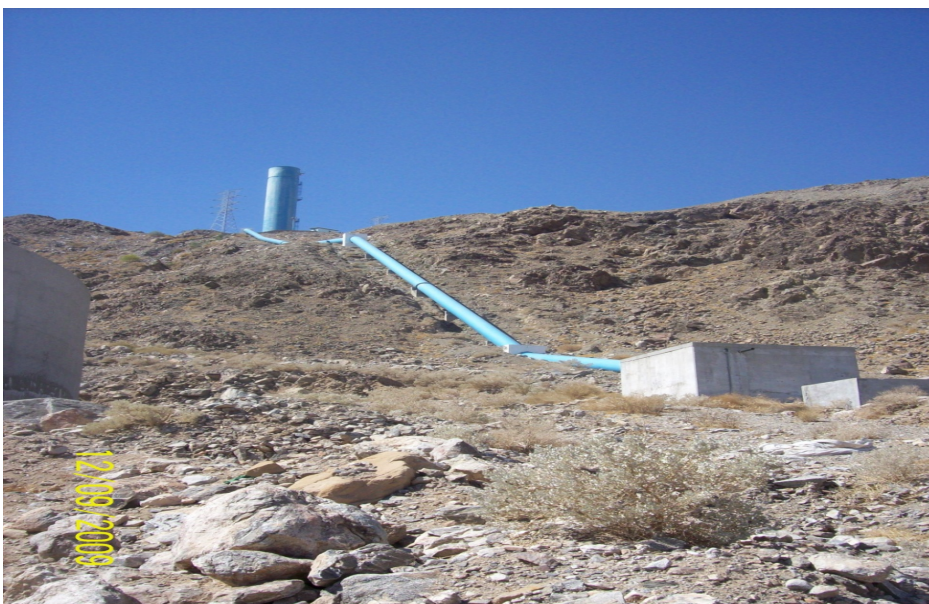
Figura 1.6. Ampliación del Acueducto Río Colorado -Tijuana.
