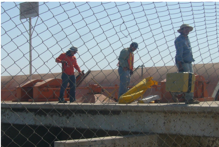
Figura 2.9. Recogiendo equipo de levantamiento en compuerta km 4+420.
