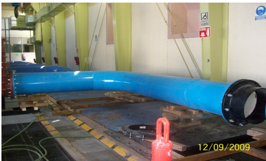
Figura 1.4. Ampliación del Acueducto Río Colorado -Tijuana. Fuente: Comisión Estatal del Agua 2008.
