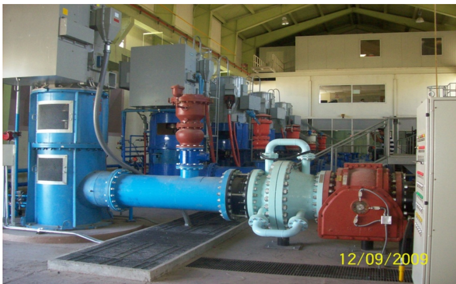
Figura 1.3. Ampliación del Acueducto Río Colorado -Tijuana. Fuente: Comisión Estatal del Agua 2008.
