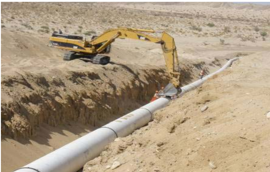
Figura 1.5. Ampliación del Acueducto Río Colorado -Tijuana.
