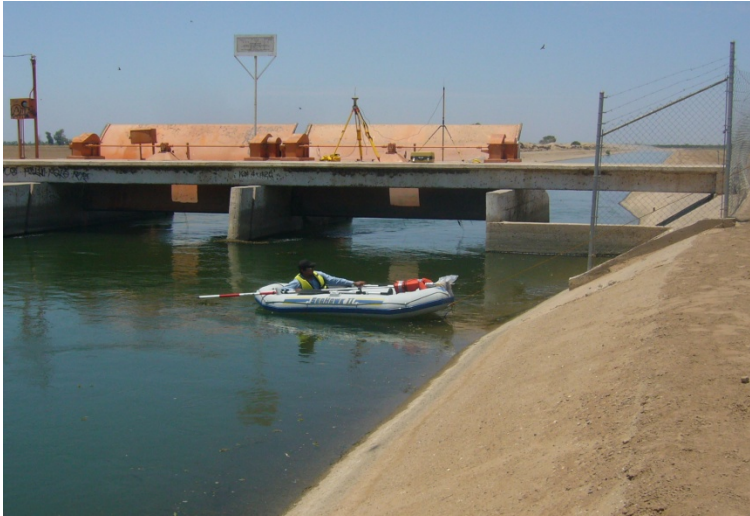
Figura 2.7. Base instalada en compuerta km 4+420. Fuente: Este estudio.
