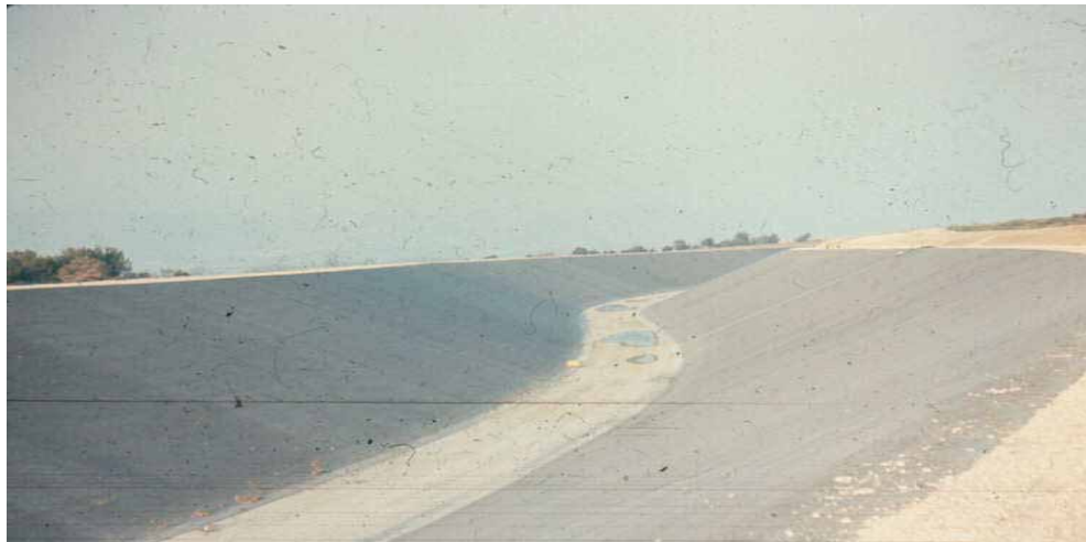
Figura 3.15. Canal Independencia en proceso de terminación.
