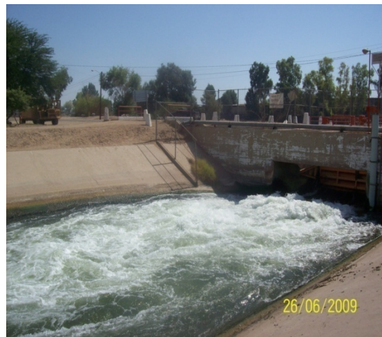
Figura 4.3. Bocatoma Sur Canal Independencia derivado del Canal Alimentador Central.
