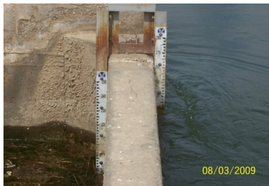
Figura 4.21. Tirante para el Canal Independencia en Concreto Asfaltico km 13+800.
