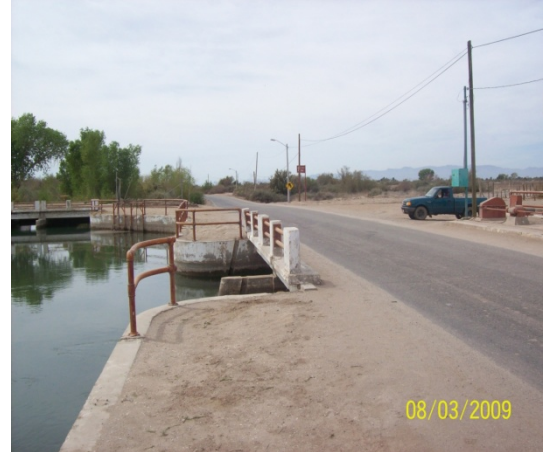
Figuras 4.8 y 4.9. Bocatomas Sur y alimentación de represo Benassini para el Canal Independencia alimentando el tramo de Concreto Hidráulico del Km 26+955 al 56+623.
