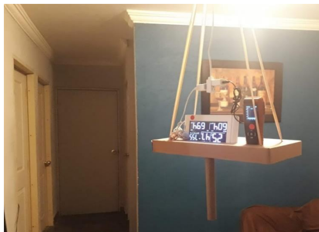
Figura 44. Base para colocación de sensores al interior de la vivienda. Elaboración propia
