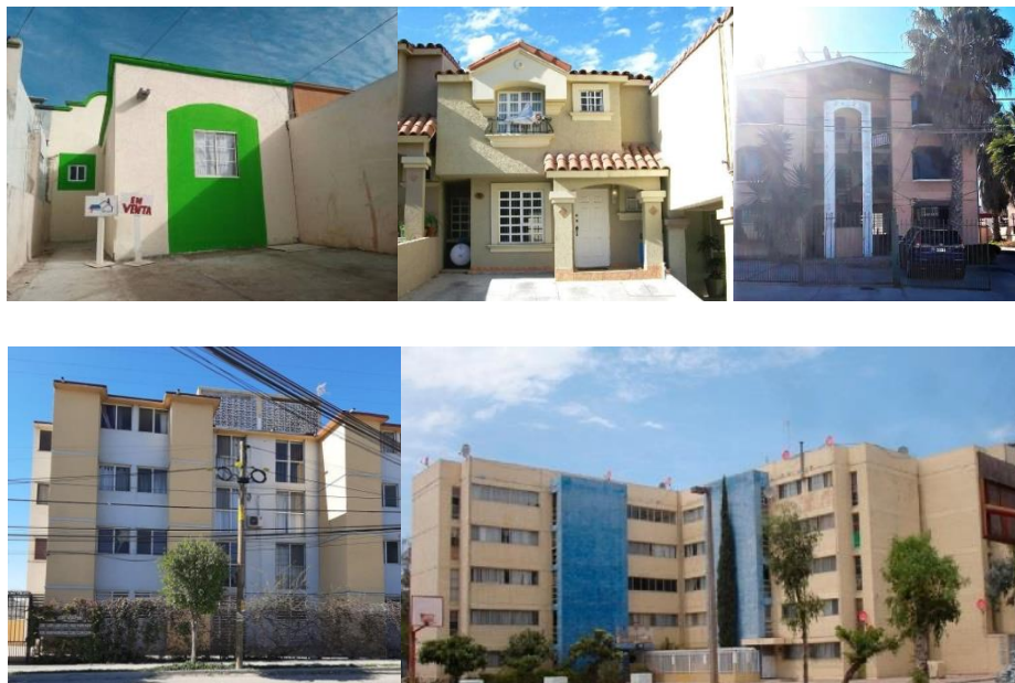
Figura 2.3. Viviendas típicas de mampostería de la ciudad de Tijuana (1 a 5 pisos).
