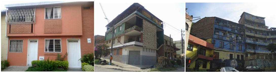
Figura 1.16. Ejemplos de estructuras de mampostería no reforzada de Antioquia Colombia (Acevedo et al., 2017).
