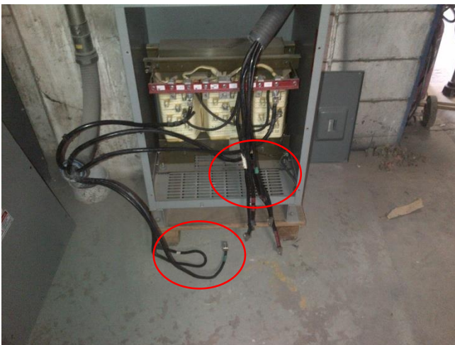
Figura 5.21 Detalles de la instalación del nuevo transformador de 45 kVA que alimenta al equipo de resonancia magnética.
