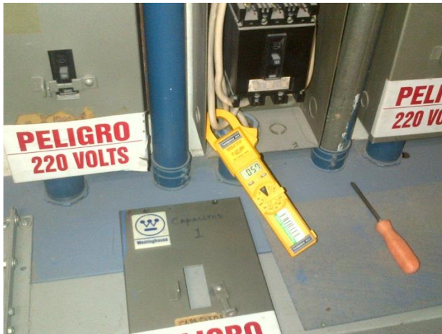
Figura 5.27 (a y b) Revisión de bancos de capacitores en conectados al transformador #2.
