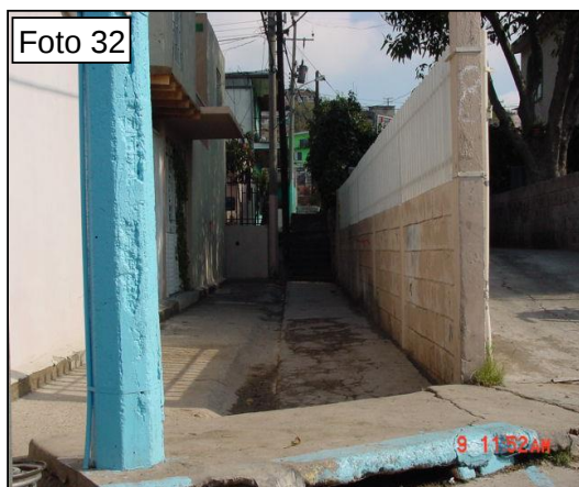
Toma hacia el Andador 6 del DT279-162 al DT279-151.
