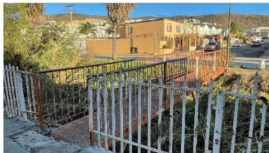
Figura 2. Puente que conecta las vialidades.
