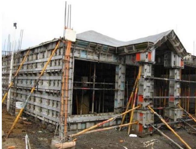
Figura 2.6 Sistema manoportable para la construcción de viviendas unifamiliares de concreto
