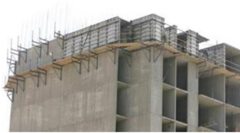
Figura 2.7 Sistema manoportable para la construcción de viviendas multifamiliares de concreto
