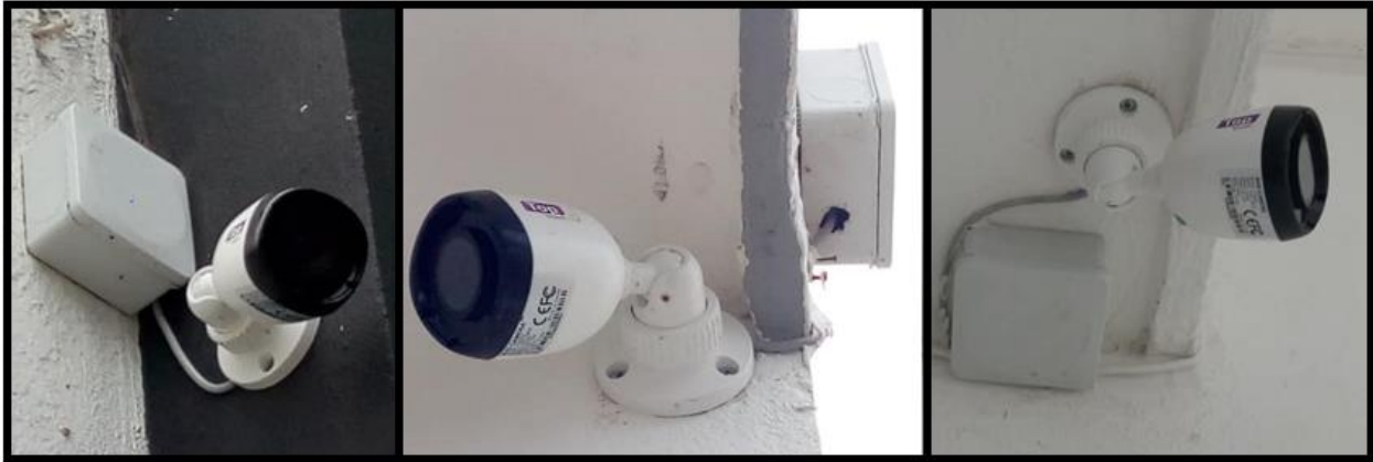
Fuente: Imagen de elaboración propia – Trabajos previos.
