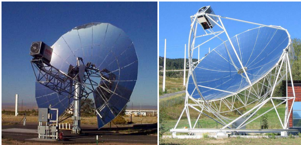
Figura 2.1. Sistemas de generación eléctrica Disco-Stirling: a) Sistema ADDS, b) Proyecto EuroDish.
