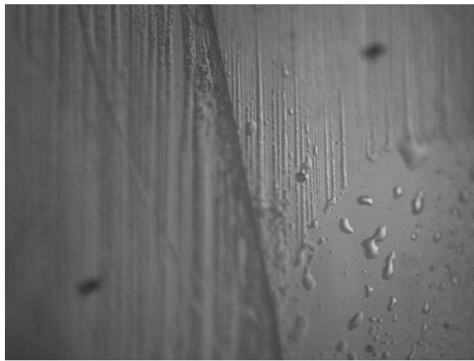
Figura 2.8 Fotografía de un defecto superficial
