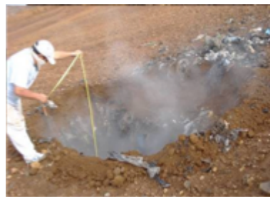
Figura 6. Medición de la profundidad de los pozos.
