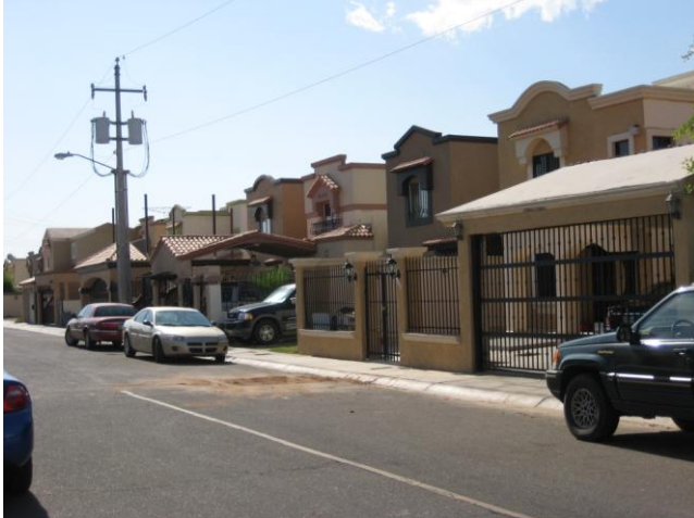
Imagen 26. Aspecto de Fraccionamiento cerrado. (Montecarlo Residencial III Etapa)
