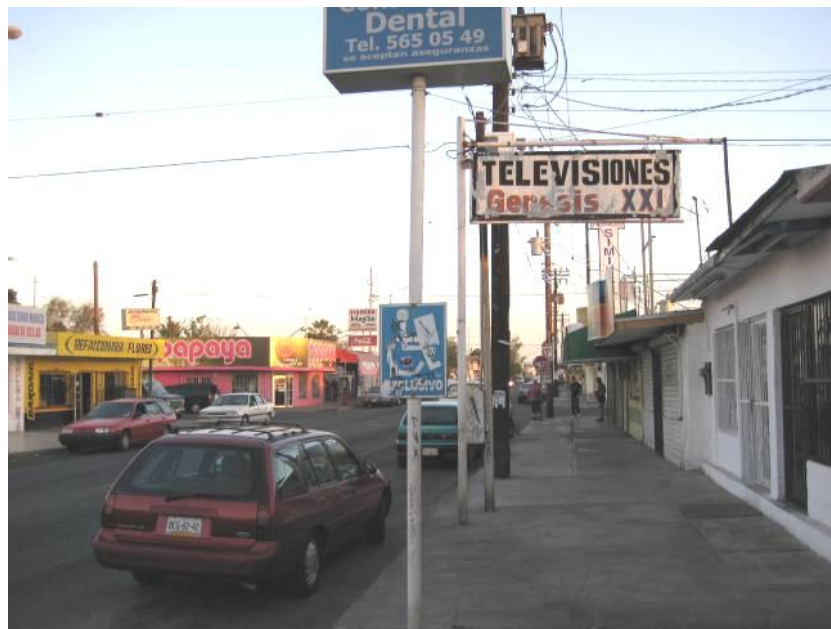
Imagen 25. Aspecto de corredores comerciales en la zona con fraccionamientos abiertos.
