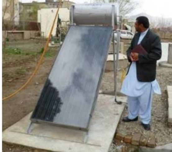
Ilustración 5. Calentador solar para una planta de biogás en Afganistán. (MEARS & ANDERSON, 2011)
