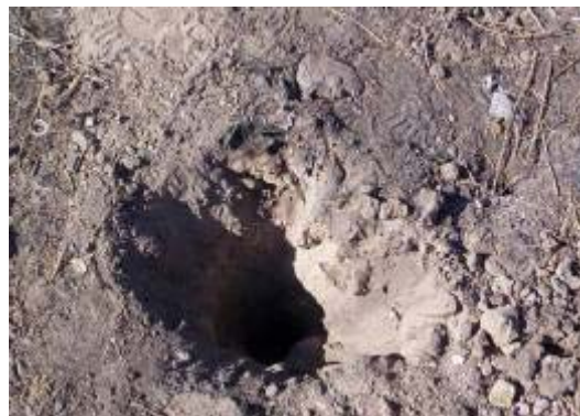
---Fig. 2--- Se observa la marca después de introducir el ciclón para tomar una muestra de suelo a profundidad de un pie.
