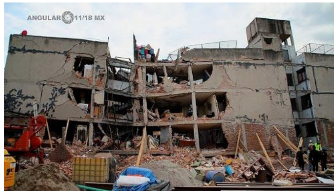
Figura 2.13. Edificio dañado en CDMX en 2017. Fuente http://angular11-18mexico.com.mx/2017/09/21/19-de-septiembre-2017-sismo-7-1-richter-a-las-1314-hrs-en-la-ciudad-de-mexico/
