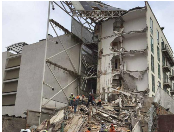
Figura 2.12. Edificio dañado en CDMX en 2017. Fuente
