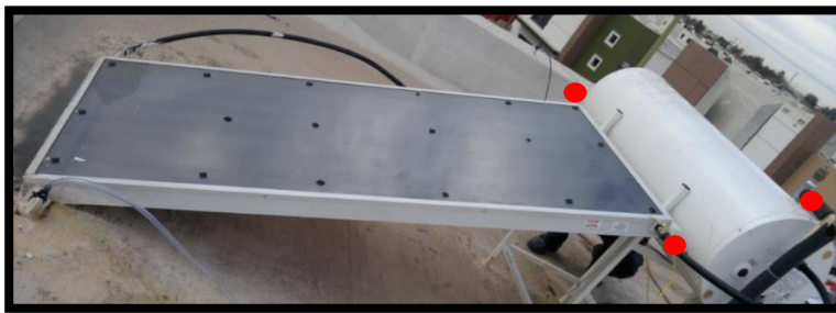
Figura 5.6. Calentador solar de agua instalado en residencia de Mexicali.
