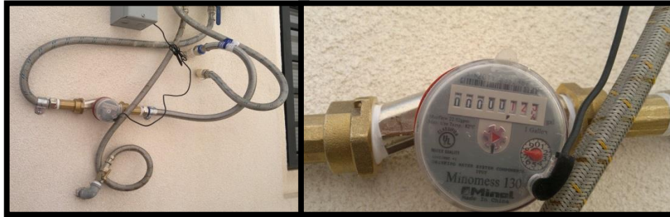
Figura 5.10. Flujómetro totalizador con pantalla análoga y cable de registro de activación digital.
