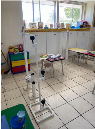
Figura B5. Instalación final de sensores de iluminancia, CO_2 y T_r , preescolar A Fuente. Fotografía tomada por el autor
