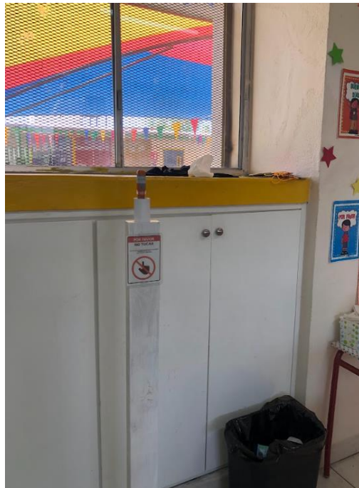
Figura B3. Instalación final de sensores de TBS y HR, preescolar A Fuente. Fotografía tomada por el autor
