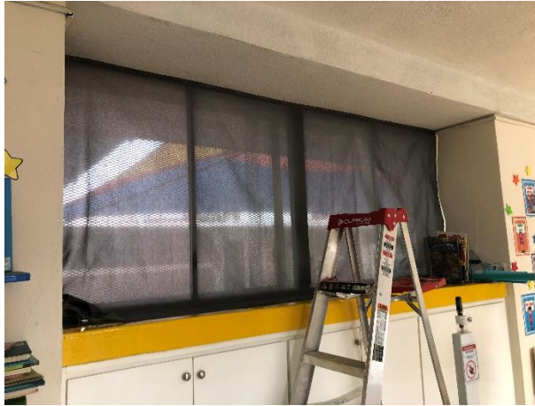
Figura A11. Instalación de tela en ventanas del aula preescolar. Fuente. Fotografía tomada por el autor
