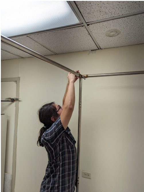
Figura 4.17: Construcción de la estructura de la jaula
