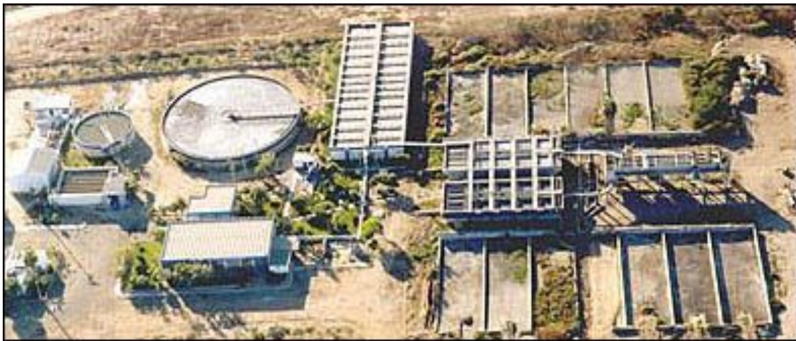
Planta de Tratamiento de Aguas Residuales “El Gallo”
