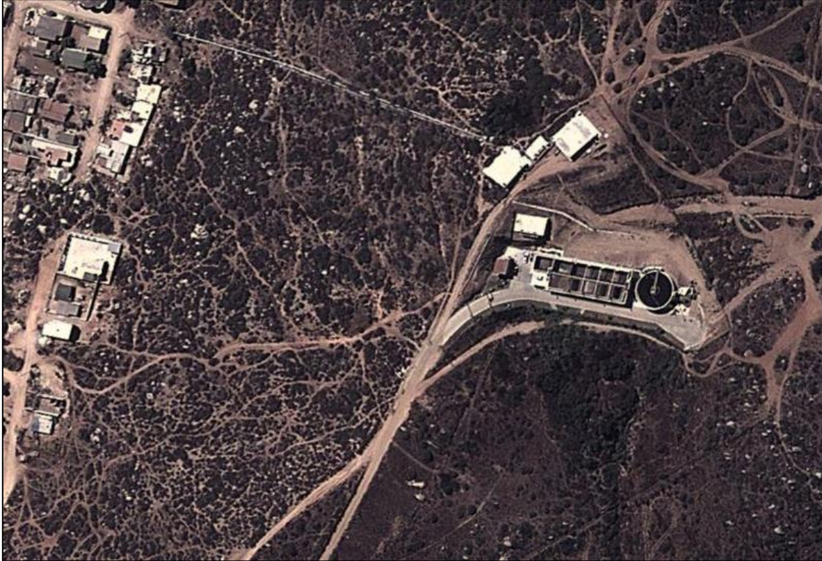
Planta de Tratamiento de Aguas Residuales “Zona Noroeste”
