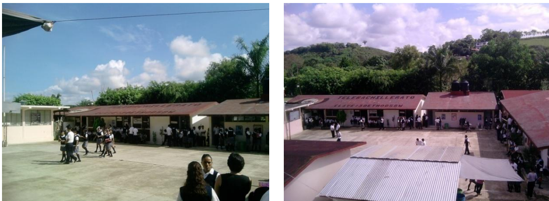
Figura 6.- Instalaciones de la escuela Telebachillerato Colonia Libertad.
