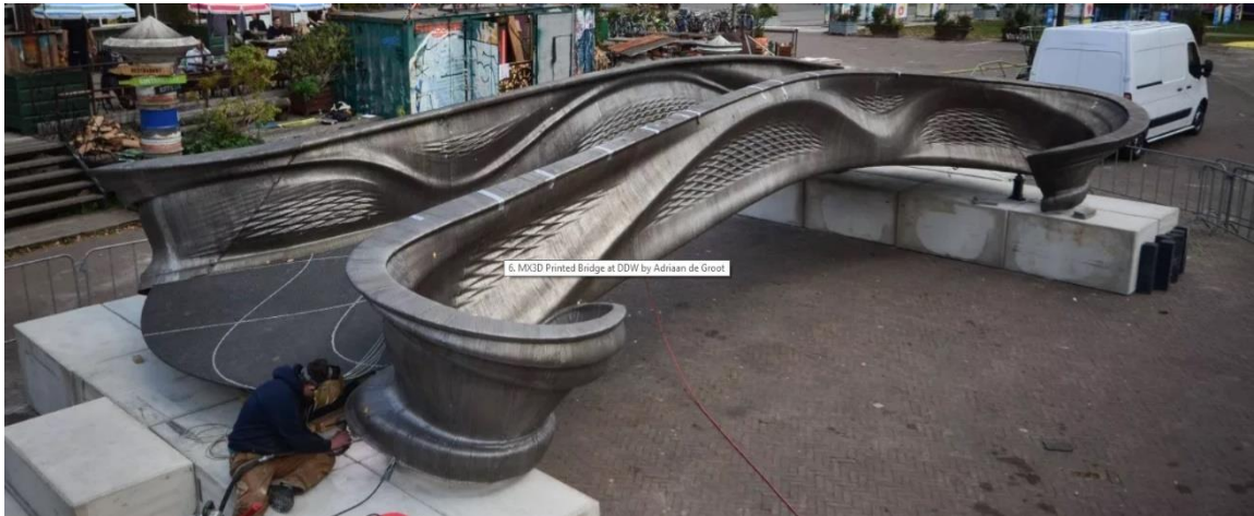
Figura 1. Puente fabricado por la empresa MX3D en Ámsterdam. Adrián de Groot
