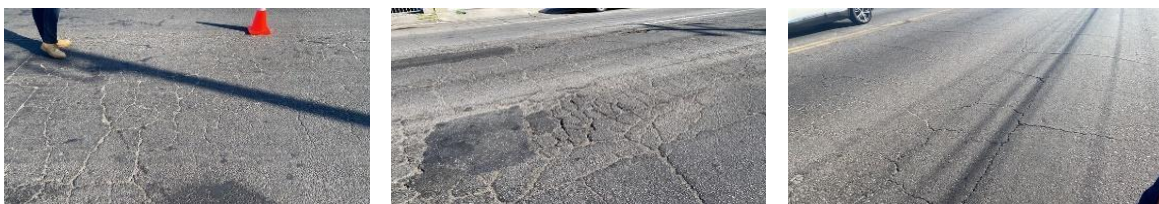
Figura 4. Referencia de PCI “Regular”.
