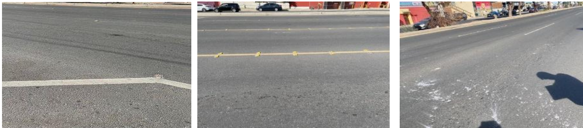
Figura 1. Referencia de PCI “Excelente”.
