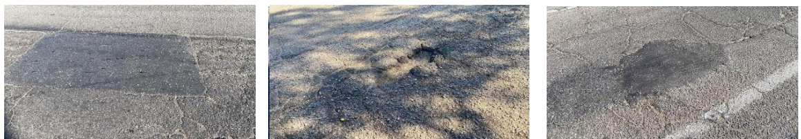
Figura 5. Referencia de PCI “Malo”.
