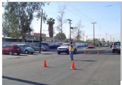
Via río Culiacán, desviación del tráfico
