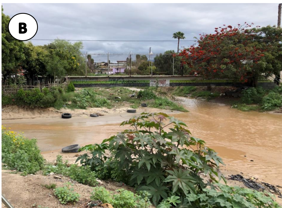
Figura 3. Se puede observar el estado actual del arroyo con llantas, basura y vegetación dentro del cauce. Fuente: Propia
