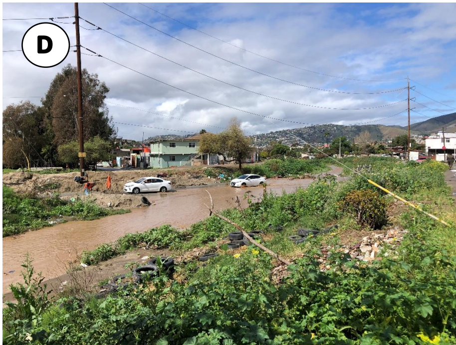
Figura 5. Se observa un cruce de automóviles y basura dentro del cauce del arroyo. Fuente: Propia
