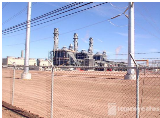
Figura 3. Central Termoeléctrica de Ciclo Combinado "La Rosita"
