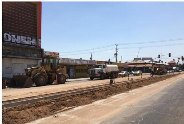
*Fotografía 5.- Excavación a partir del camellón existente para preparación de ciclovía, agosto de 2016. Fotografía de la autora.*
