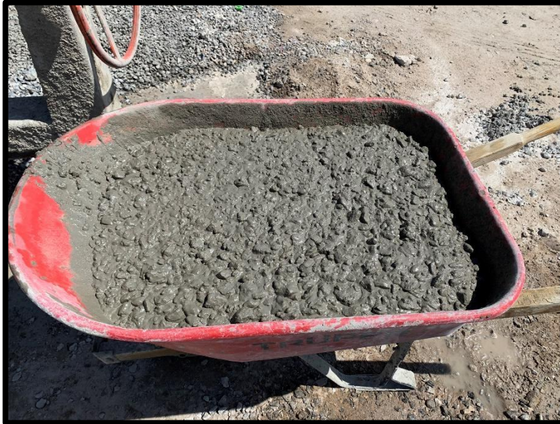
Figura 39. Muestreo de la mezcla de concreto.
