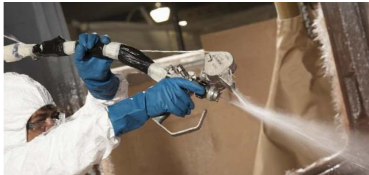
Figura 28. Rociado de resina y fibra de vidrio cortada.
