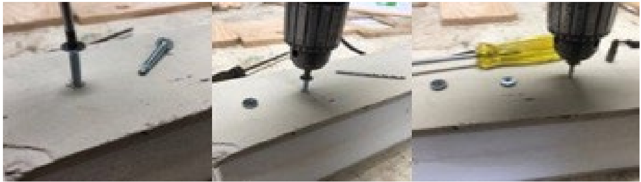
Figura 26. Operaciones de barrenado. Elaboración propia.
