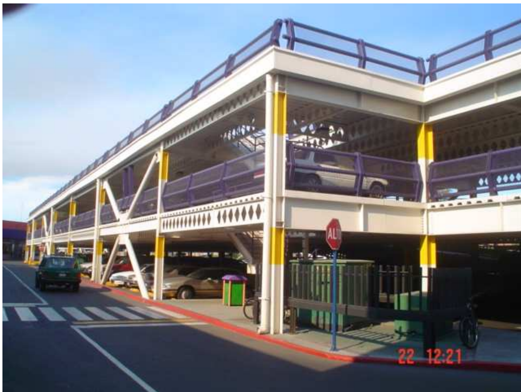
Figura 5. Estacionamiento “Plaza Río”, Tijuana, B.C.
