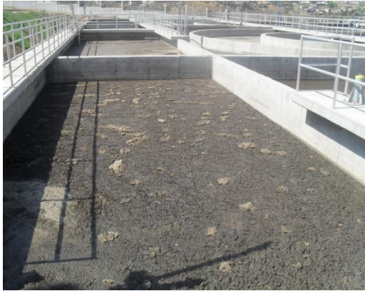
Figura 8. Reactores anaerobios.
