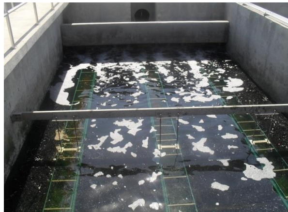
Figura 12. Filtración en arena.
