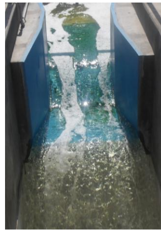
Figura 14. Efluente de la PTAR "Monte de los Olivos".
