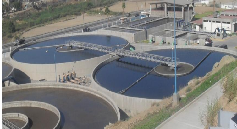
Figura 11. Clarificadores circulares.
