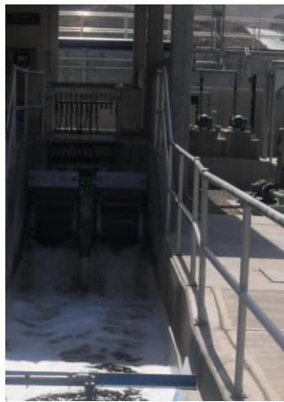
Figura 13. Desinfección ultravioleta.
