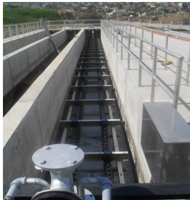
Figura 7. Desarenador gravimétrico.
