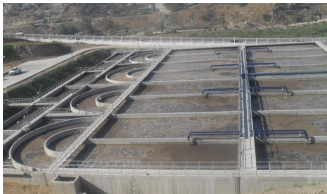
Figura 10. Reactores aerobios.
