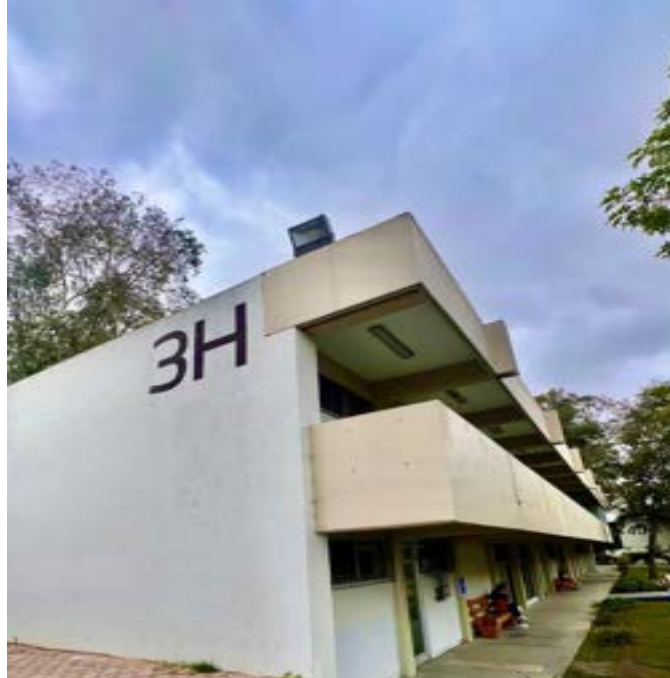
Figura 10. Edificio 3H de la Facultad de odontología. En la figura 10 se ilustra el edificio 3H de la Facultad de Odontología Campus Tijuana
