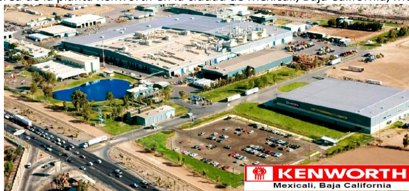
Figura 21. Vista aérea de la planta Kenworth en la ciudad de Mexicali, Baja California, México.
