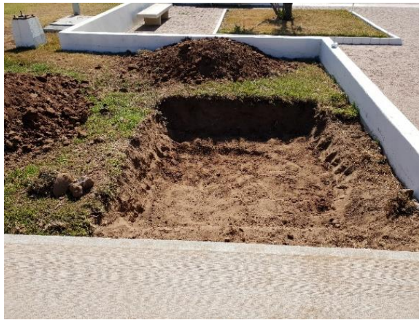
Figura 56: Excavación, zona experimentación
