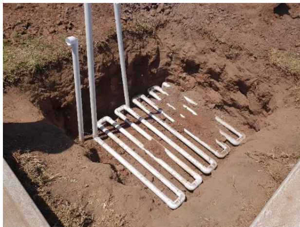
Figura 57: Colocación de ductos
