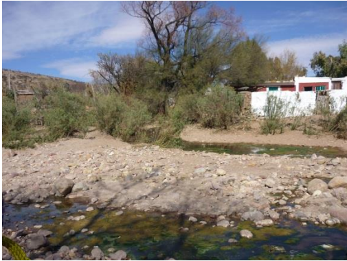
Figura 1 Cauce erosionado por asentamientos humanos a orillas del río en Luis Moya.
