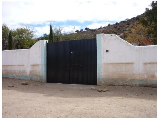
Figura 3 Marca de nivel de agua alcanzado por desbordamiento del río. La vivienda en la foto se encuentra a aproximadamente 30 m del río, en la localidad de Luis Moya.
