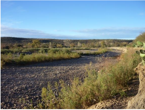
Figura 7 Zona erosionada mencionada en la figura 6. Localidad Huajota.
