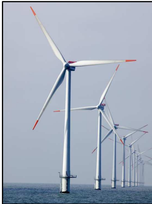
Figura 1.4: Parque eólico Horns Rev, en Dinamarca uno de los parques eólicos en el mar más grandes del mundo.
