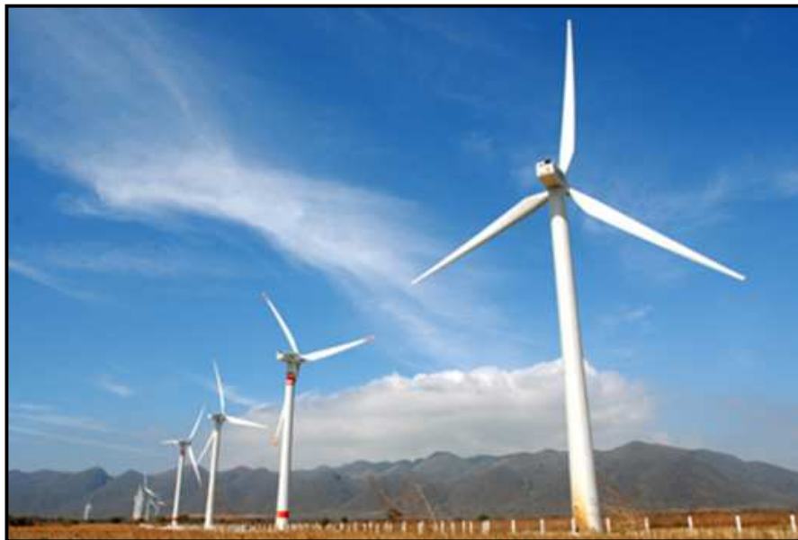
Figura 3.13: Central eólica La Venta II, Oaxaca, México.
