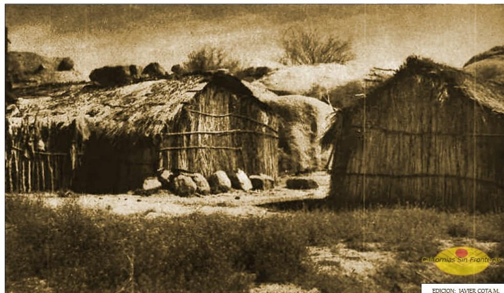
CASAS PAIPAI EN SANTA CATARINA, BAJA CALIFORNIA ( 1952 )
