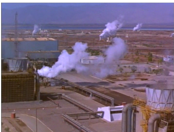
Fotograma 14. Tomas de la geotérmica desde el helicóptero.
