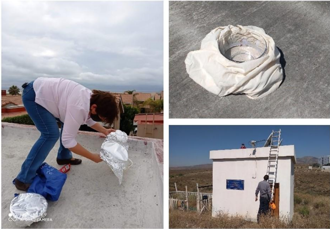
Figura 4.2. Colocación de recipientes refractarios para recolectar deposición de MPs en techos de edificaciones de una planta.
