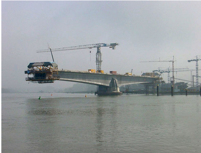
Figura 2: Estructura en voladizo.
